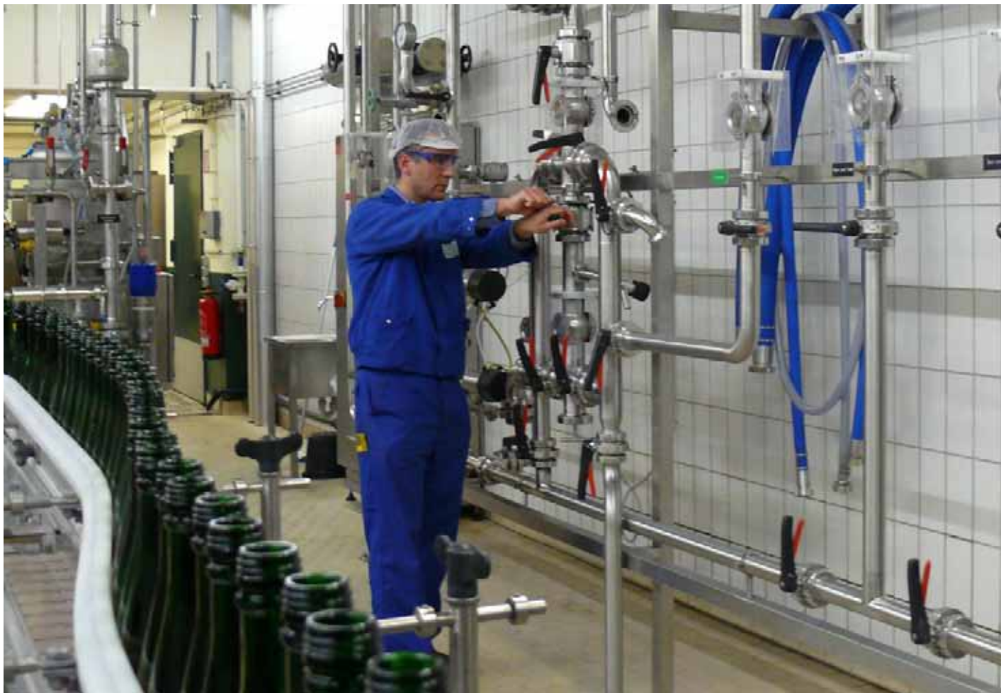
Kontrolle einer Molchanlage während des Produktionsprozesses durch unser geschultes Fachpersonal
