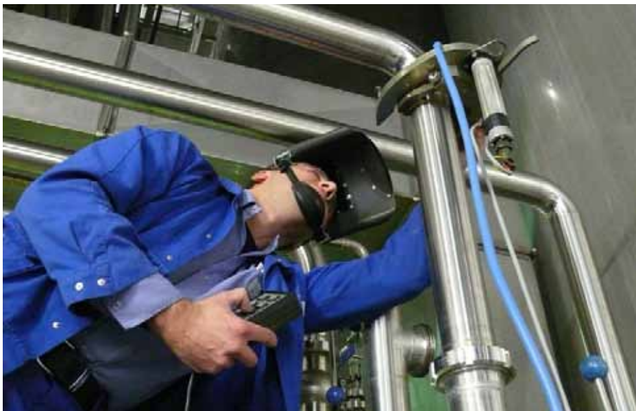
Schweißvorbereitung und Einjustierung der Orbitalschweißzange
