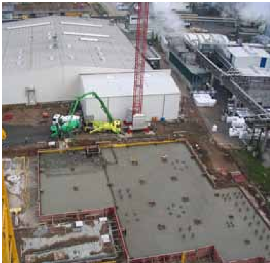
Errichtung eines 3400 m 2 und 5100 m 3 großen Fundaments für ein Industriegebäude
